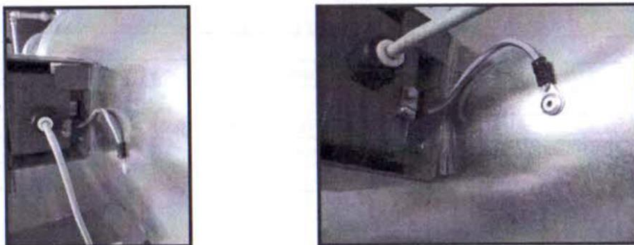
Figura 31: Fotografía de la conexión eléctrica (Tierra) de un sensor detector de chispa GMSC243T(-EX) en un ducto.
